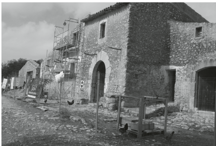
2022. Obres al Centre de Recerca del Patrimoni Arqueològic.
