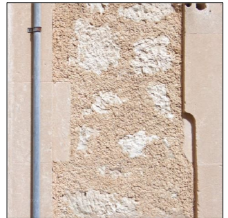
Mur de paredat verd, amb referit parcial amb base de morter de calç
