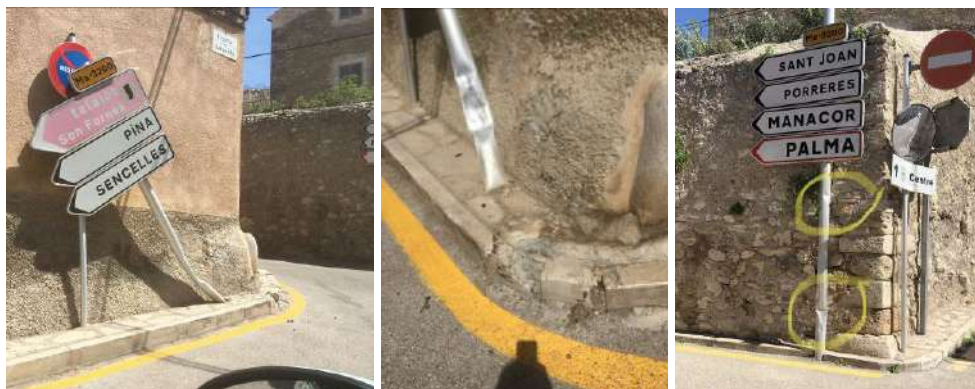
Resultado de las colisiones de los vehículos por exceso de velocidad
