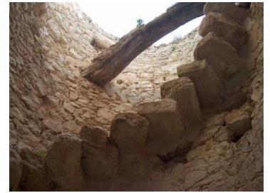
Escala interior de la torre
