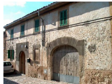
Imatge interior a la reforma
