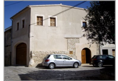
Imatge anterior a la reconstrucció
