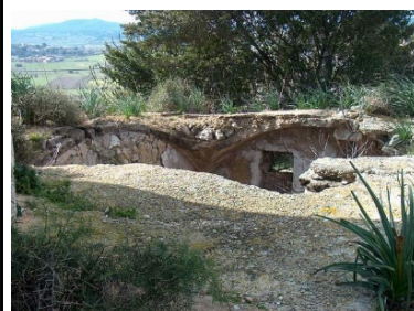
Restes de la terrassa amb la forma de les voltes
