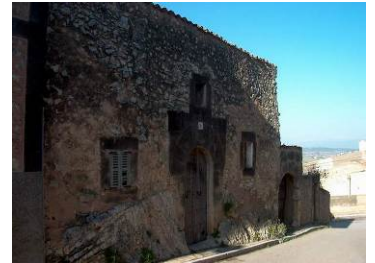
Façana abans de la reforma
