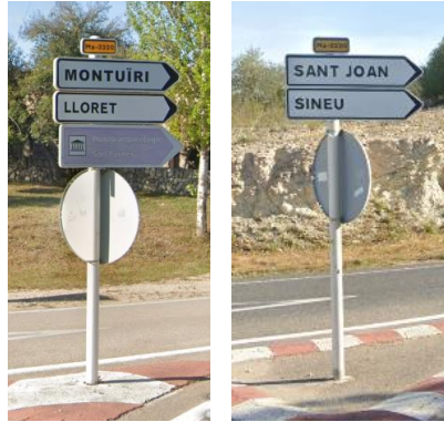
Figura 27: Senyal vertical d'orientació de la rotonda de la Ma-3210 en direcció al nucli urbà seguint la ctra. Ma-3220 (esquerra) i senyal vertical d'orientació de la rotonda en direcció a l'est per la carretera Ma-3220 (dreta)
