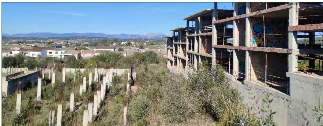
Fotografies 50: Estat actual de l'AT02, on hi trobem edificacions sense acabar. Punt u57. Font: ACC 2024.
