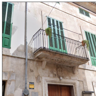
Balcó de planta primera amb baranes de ferro forjat i mènsules
