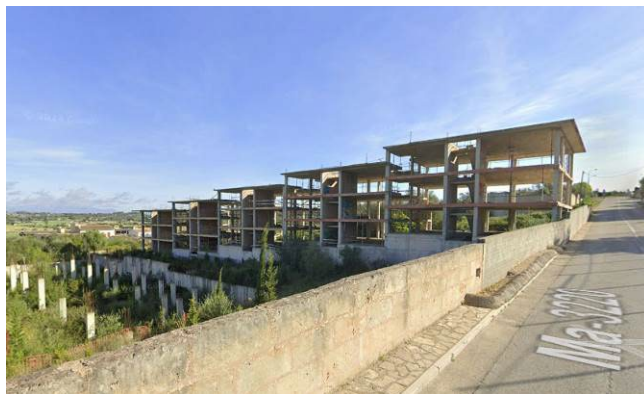
Bloc abandonat a recuperar
